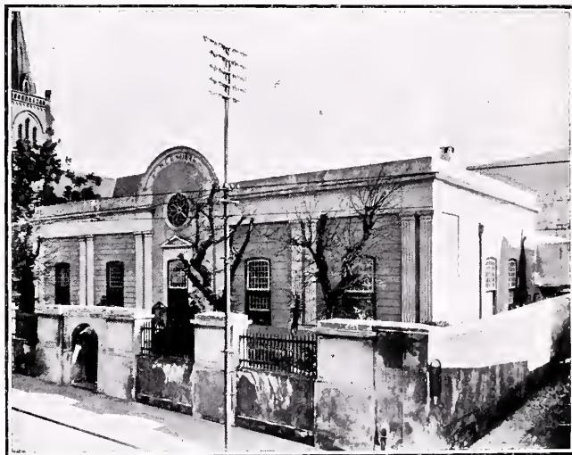
Het Oude Weeshuis, Lange Straat, Kaapstad.
